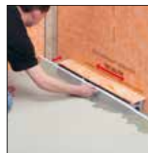
ad 4. Vyrovnání nosného prvku žlabu
