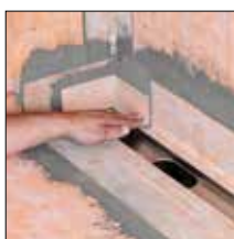
ad 3. Nalepí se KERECK vnitřní kout
