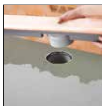
ad 4. Nasazení tělesa žlabu včetně nosného prvku žlabu
