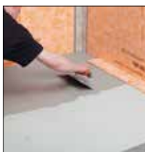
ad 6. Nanesení tenkovrstvého lepidla
