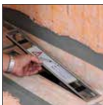
ad 1. Vloží se rám včetně distančního pásku
