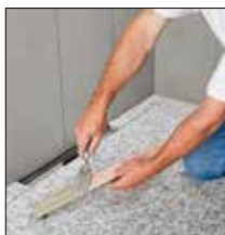
ad 5. Na nosič dlažby se nanese tenkovrstvé lepidlo
