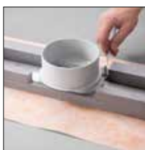
ad 3. Opětovné přišroubování adaptéru
