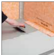
ad 7. Nanesení tenkovrstvého lepidla
