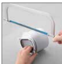
ad 2. Zkrácení adaptéru
