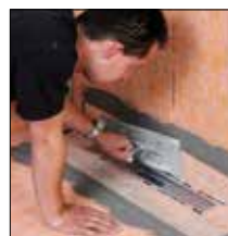
ad 4. Přilepení KERDI manžety pomocí KERDI-COLL-L
