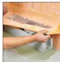
ad 2. Osazení tělesa žlabu
