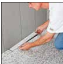
ad 6. Nalepí se dlažba - při spárování se vynechá oblast nosiče dlažby
