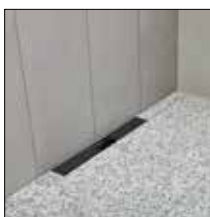
ad 3. Položí se dlažba v ploše sprchy
