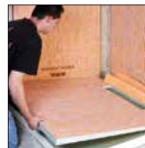
ad 3. Zasunutí spádové desky pod těleso žlabu
