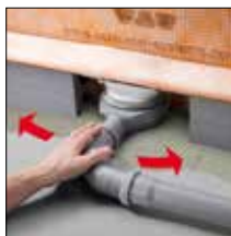
ad 5. Nastavení odpadní trubky
